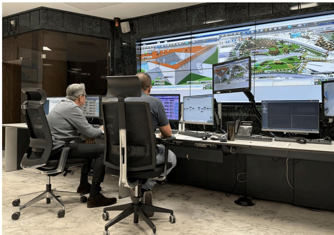
Imagen del centro de control ABC
